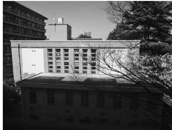
3号館北棟からみた書庫棟側面。 中央列を残して左右の窓が壁となった。
