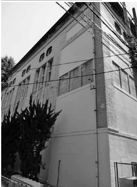
建物側面から背面にかけて 数カ所に足場が組まれ工事は進んだ。
