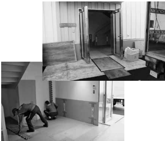
⑧⑨ (上2枚) 搬入経路を養生しています
