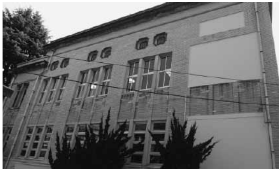
図3 耐震補強工事後の外壁
