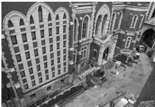
図1 工事中の旧館正面 (2017年5月) 1)
