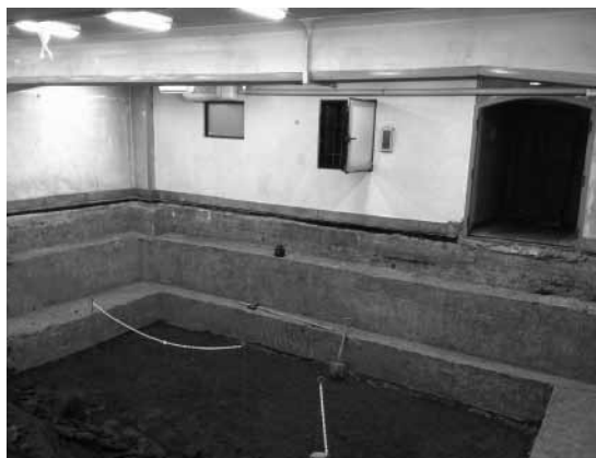
図4 床面掘削中の第2書庫地下1階（2017年4月）
