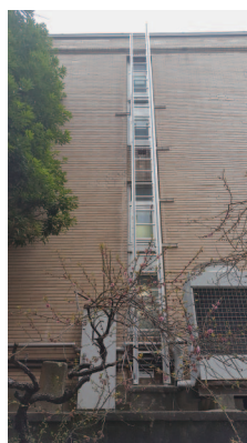
【信濃町】書庫棟に避難はしごを新設
