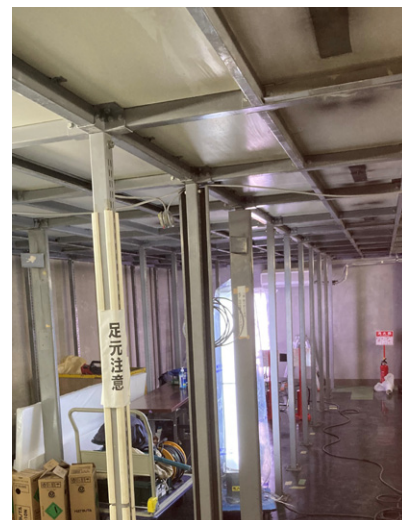
図2 1階吹き抜け工事前（書架支柱と天井がある状態）
