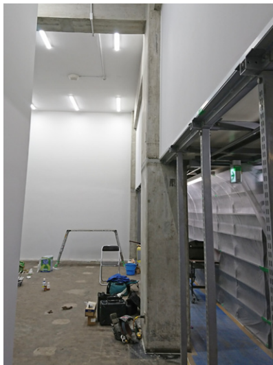
図3 1階吹き抜け工事と壁面設置（書架支柱と天井の撤去・右上部に2階の壁面設置・左手前にエレベータ内包用の壁面設置）
