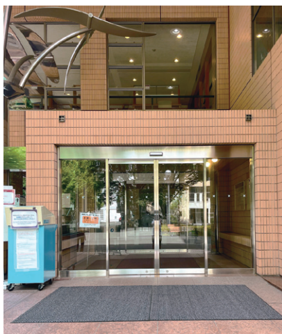
【三田】新館正面扉を自動ドアに改修（8月）
