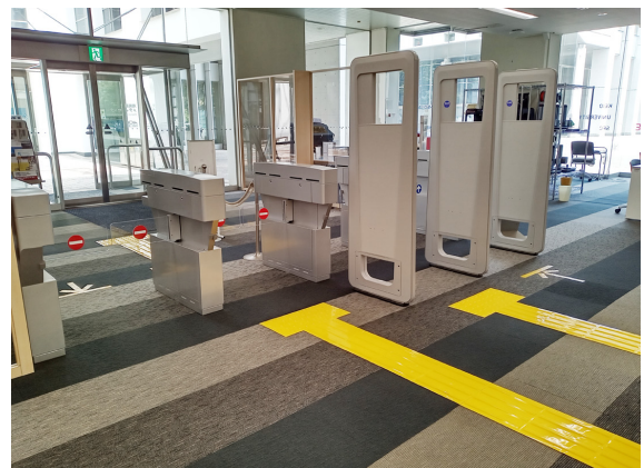
図2 湘南藤沢メディアセンター点字ブロック
